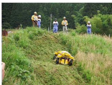
無線遠隔草刈機による法面除草
