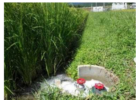
用水路をパイプライン化したほ場
