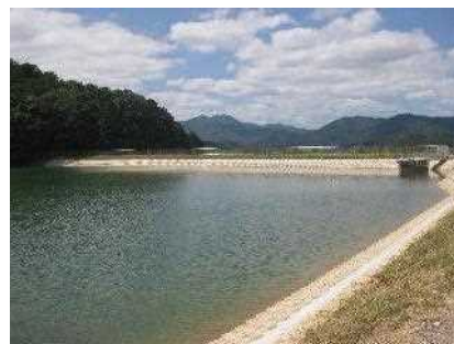
改修したため池
