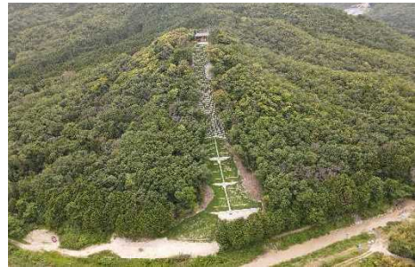
山腹斜面の拡大侵食を防ぐ山腹工
