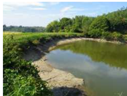
老朽化が進んだため池
