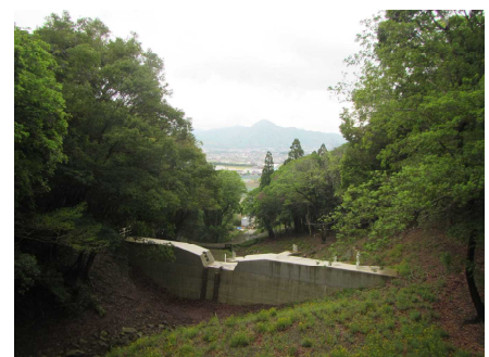
防災基盤整備（治山ダム）
