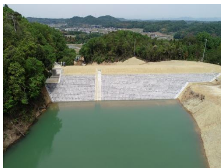
改修後の林谷池（北区）
