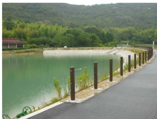
改修されたため池（高砂市）
