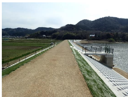
改修されたため池（加西市）
