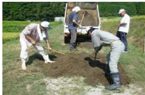
道路の補修（多可町）
