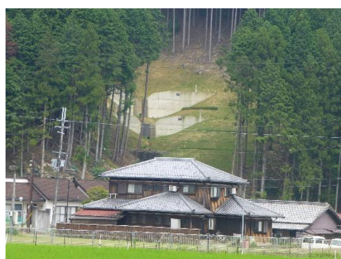
集落を守る治山ダム（多可町）
