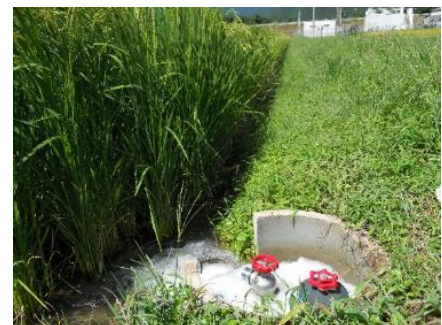
用水路をパイプライン化したほ場
