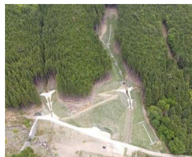
復旧治山事業（山腹工・溪間工） の実施状況（丹波市市島町与戸）
