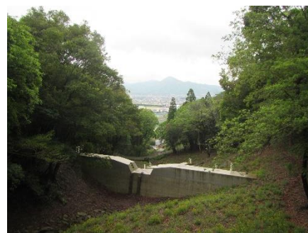
防災基盤整備（治山ダム）
