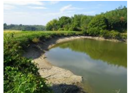
老朽化が進んだため池
