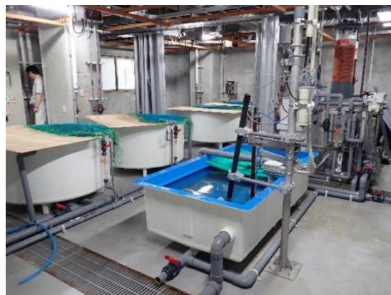
水温や塩分などを最適条件に 管理できる閉鎖循環型飼育施設
