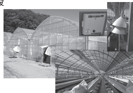
整備された園芸施設と省エネ機器（加古川市）
