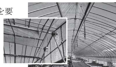
自動開閉式内張カーテンを整備したハウス（たつの市）
