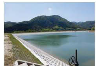
豪雨対策を実施した ため池(洲本市)
