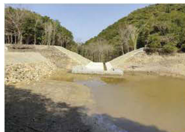
廃止工事が完了したたため池（洲本市）
