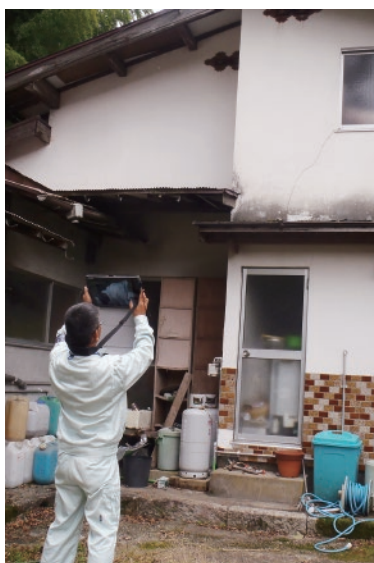
災害被害を調査しているようす
