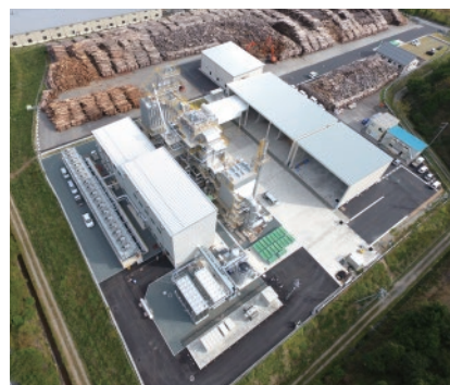
バイオマス発電所
