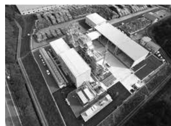
バイオマス発電所
