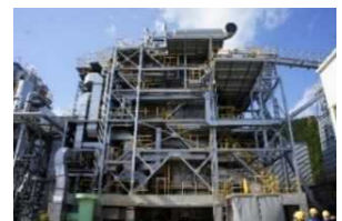
木質バイオマス発電所（朝来市）
