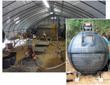
地中に埋められたバイオガスユニット
