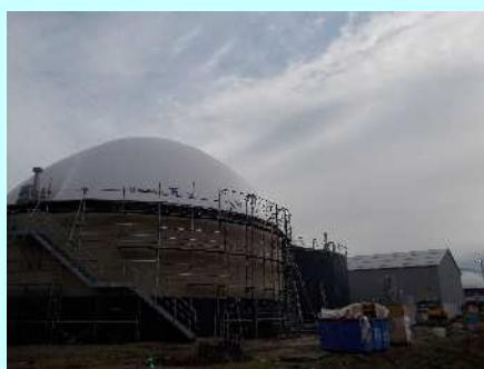
バイオガス発酵槽等の設備（工事中）
