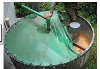
反応槽 (間伐材チップ充填機)
