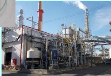
汚泥乾燥燃料と汚泥乾燥施設
