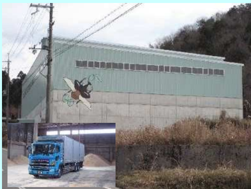
オガ粉保管施設
