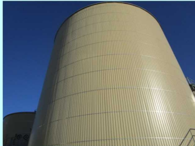
メタン発酵槽
