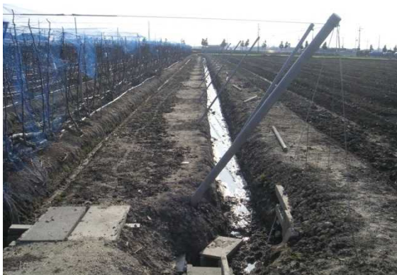
写真 2-5a 園外縁部に掘られた明きよ ともにいちじく園
