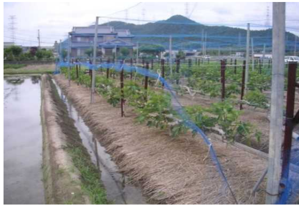
写真 2-4 上段の水田から園内に浸入した漏水
