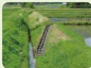
水路と水田を魚類が行き来する小水路の設置
