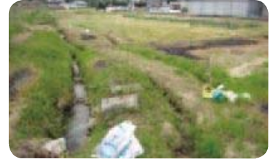
漏水が多く、用排兼用の水路
