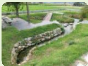
環境水路や水辺公園の整備
