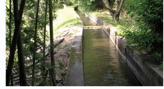
大正時代に疏水とため池を一体的に整備し、100年以上経過して現在でも西光寺野台地に用水を供給し続ける「西光寺野疏水路」は、歴史的価値と当時の技術力の高さが評価され、令和6年に世界かんがい施設遺産に登録されました。【写真29:山麓を流下する疏水路（市川町西田中）】
