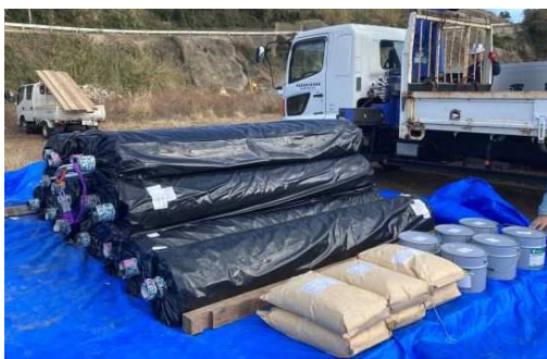
参図-3.4.1 荷下ろし時の状況（左）、ブルーシートによる養生例（右）
