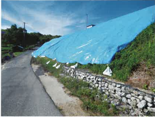
ブルーシートによる応急措置の状況
