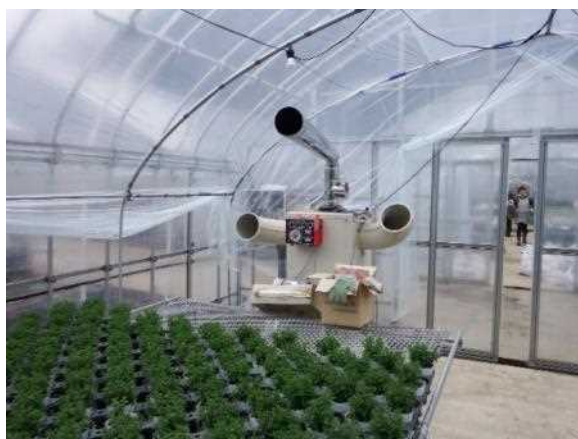
4段サーモスタット装置設置状況
