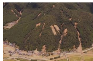
H26 山腹崩壊(丹波市)
