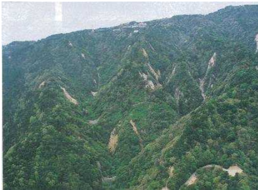
写真 1. 2. 3 神戸市灘区六甲山町（赤滝谷）での崩壊 1)
