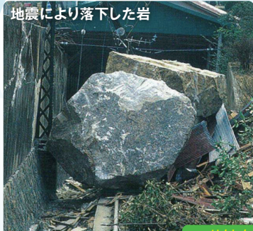
地震により落下した岩
