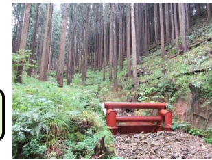
緊急防災林整備（斜面对策）
