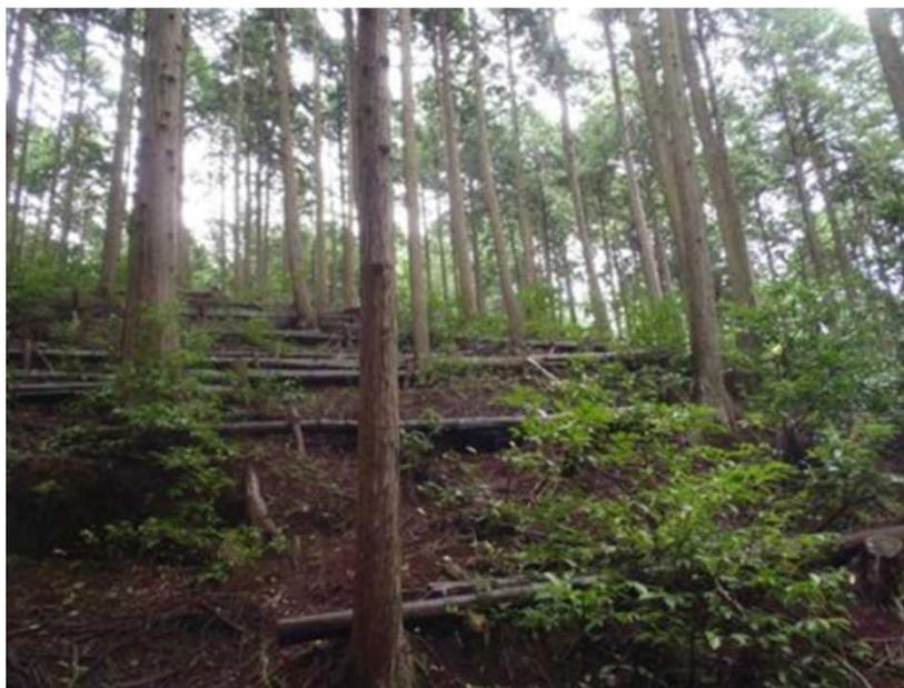
写真 土留工の設置状況
