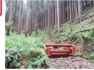
緊急防災林整備（斜面对策）
