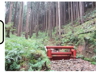
緊急防災林整備（斜面对策）
