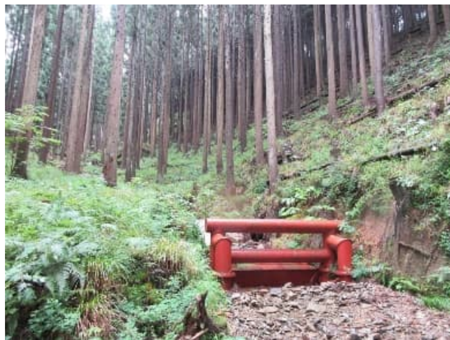
写真 簡易流木止め施設
