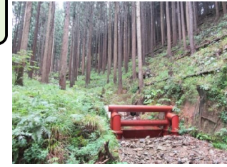
緊急防災林整備（斜面对策）
