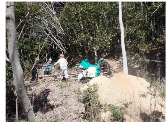
チップパーを活用して伐採竹を処理
