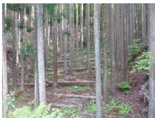
土留工施工直後
