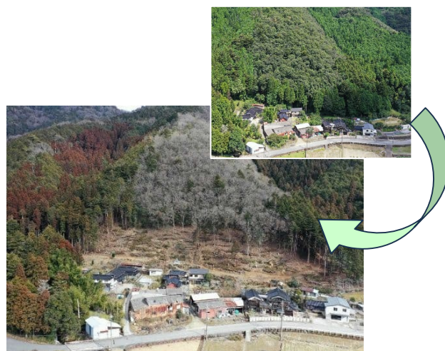
整備直後の状況
