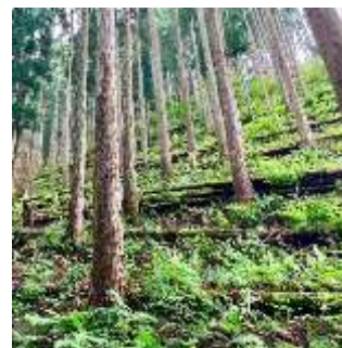
伐採木を使用した土留工 (養父市)
