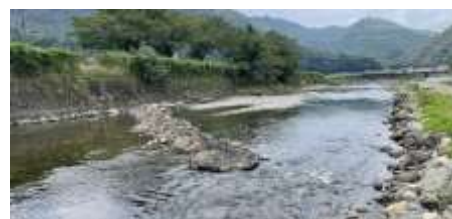
魚類の生息場に適した環境(寄州や瀬・淵)を創出するバープ工* *河岸から上流側に向けて構造物を設置する水制工法
