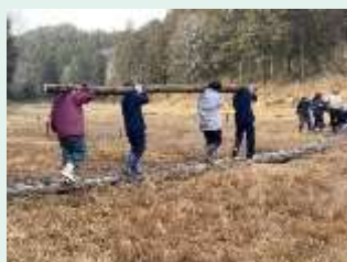
湿原内の木道の修繕
