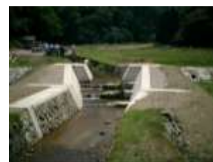
堰堤から越水させて洪水を緩和
