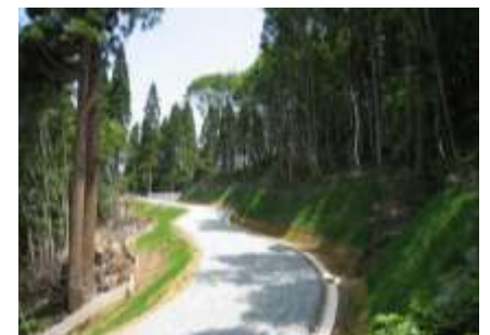
林道設計における現地地形に沿った波型線形の採用 (在来種の生息・移動空間の確保)
