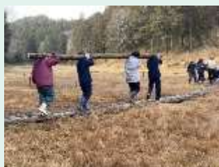
湿原内の木道の修繕
