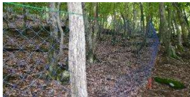
植生保護柵の設置(宍粟市)
