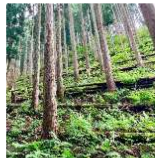
伐採木を使用した土留工 (養父市)
