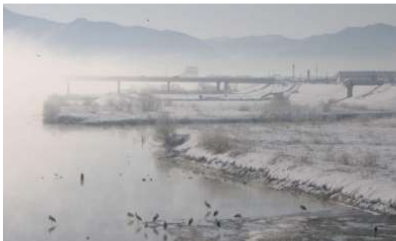
高水敷を切り下げて、治水と環境が両立するようにコウノトリの生息環境を創出（円山川水系豊岡市）
