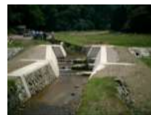
堰堤から越水させて 洪水を緩和
