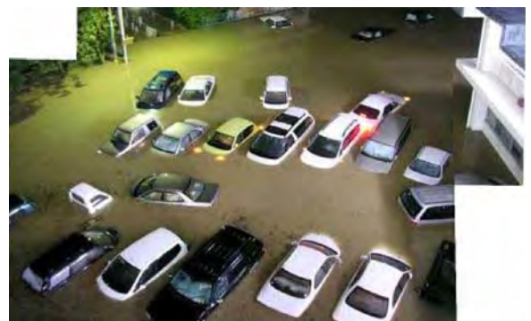
県洲本総合庁舎(洲本市) 浸水状況
