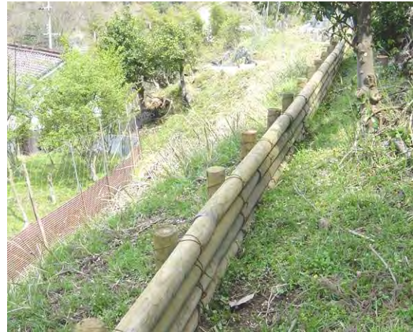
人家への土砂流出を防ぐ丸太柵工
