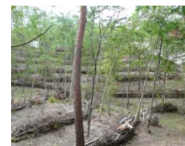
過密林分のため下層植生が消失 本数調整伐後に、土留工を設置
