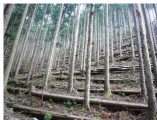
伐倒木を利用した土留工の設置 土砂流出抑止と植生回復状況
