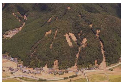
谷頭部の凹型斜面で多発した崩壊 (丹波市市島町前山川流域 国土地理院撮影)
