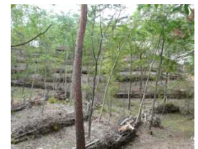
本数調整伐後に、土留工を設置
