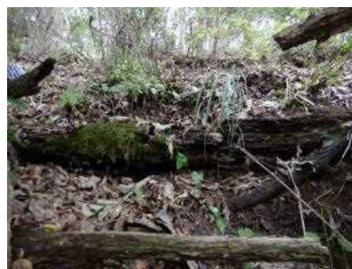
図4-2 整備後10年の土留工の状況、土留工背面に植生が見られる
