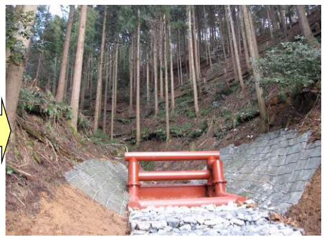
簡易流木止め施設の設置
