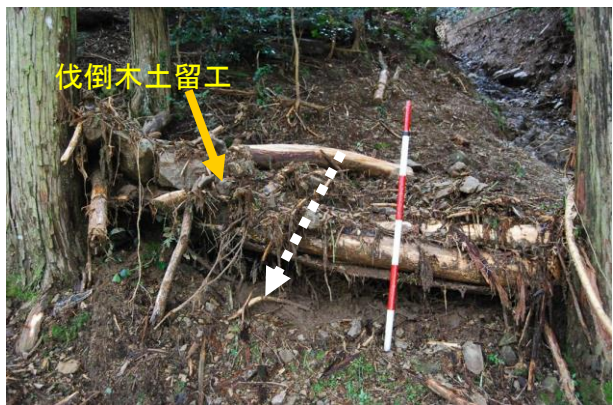
土留工が流出土砂を抑止(21年8月豪雨)
