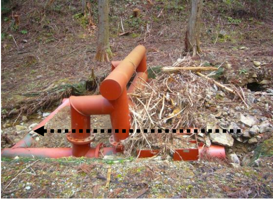
◆23年台風第12号災害での整備効果 〔22年度整備地：簡易流木止め施設が土砂等を抑止(多可町)〕
