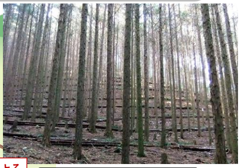
伐倒木を利用した土留工
