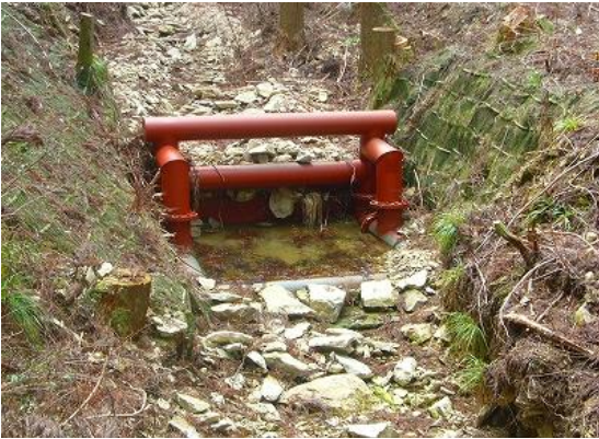
◆23年台風第12号災害での整備効果 〔22年度整備地：簡易流木止め施設が土砂等を抑止(多可町)〕
