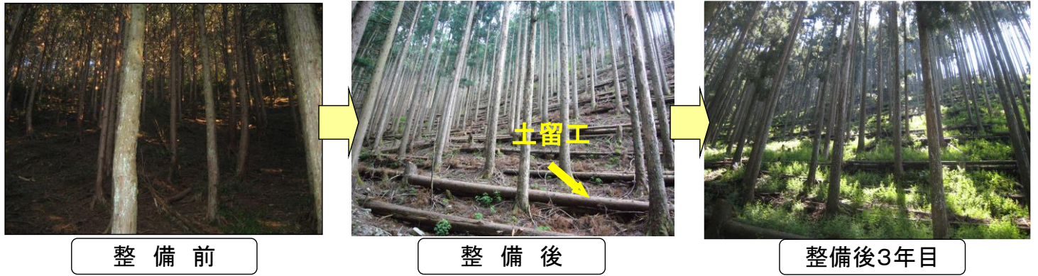
土留工を設置したスギ林 《養父市大屋町》
