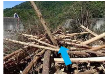
流木の堆積状況
