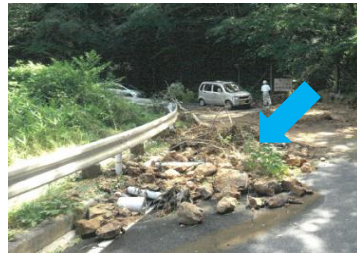
未整備の溪流から土石が流出
