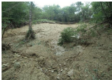
急峻な斜面での表層崩壊
