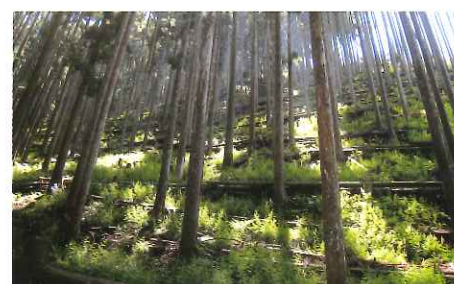
土留工の設置により下層植生が回復し表面侵食防止機能が向上
