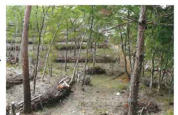
過密林の間伐後に、土留工を設置
