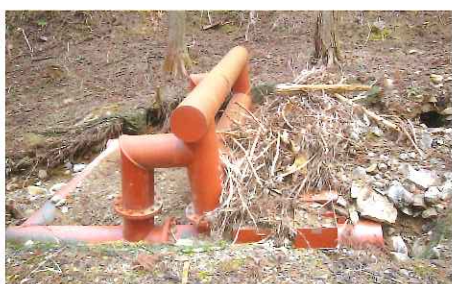
簡易流木止め施設が流木を捕捉
