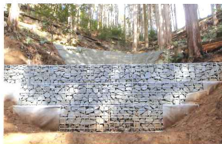
人家裏山の簡易防災施設の設置（鋼製かご柵工）
