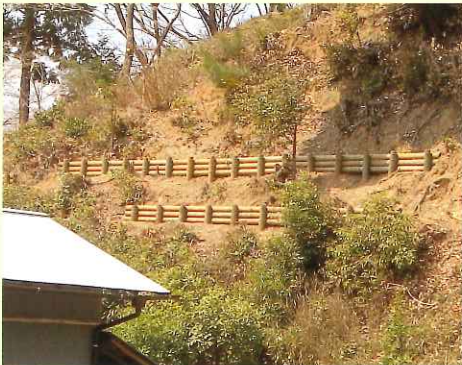
災害に強い森づくり (丸太柵工による土砂流出防止)
