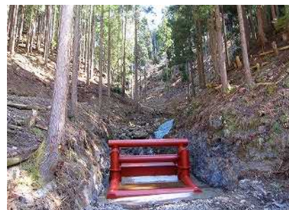
倒木・流木の伐採除去、間伐、簡易流木止め施設の設置
