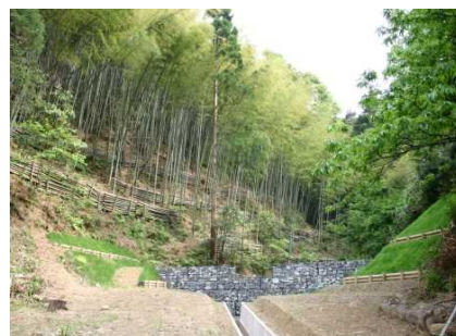
溪流の安定を図る床固工と水路工の設置 (美方郡香美町香住区三谷)
