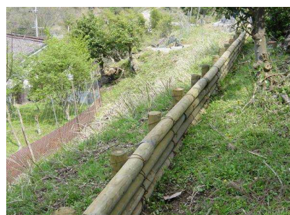
人家への土砂流出を防止する丸太柵工の設置 (佐用郡佐用町上石井)
