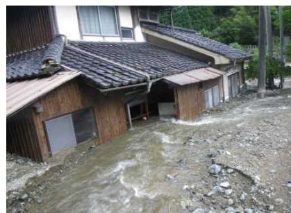
異常出水による土石流で人家が被災 （朝来市佐囊）
