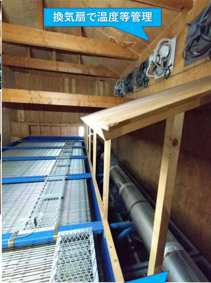
燃焼ガスを直接乾燥室に供給
