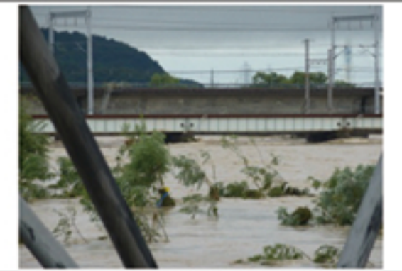
平成23年台風12号浸水状況(市川)
