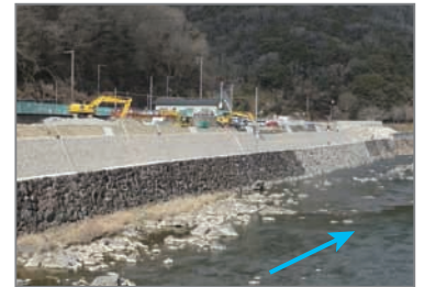
武庫川武田尾地区護岸整備[施工中] (宝塚市)
