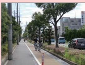
歩道のカラー舗装（ベージュ） 国道250号 (明石市)
