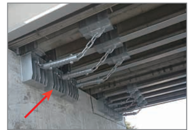
落橋防止装置 播磨大橋 県道 東播磨港線 (播磨町)
