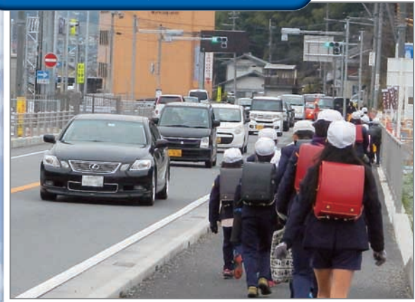
歩道整備 県道 三木穴栗線（姫路市）
