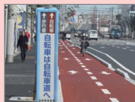
自転車道（ベンガラ） 県道 高田久々知線 (尼崎市)
