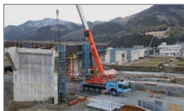
北近畿豊岡自動車道 八鹿日高道路[施工中](養父市)
