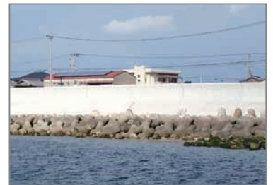
防潮堤 阿万港(南あわじ市)
