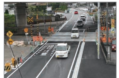
踏切部の自動車の円滑な通行対策 （車道部の拡幅） 県道 伊保阿弥陀線 尾の下東踏切 (高砂市)
