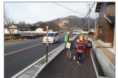
歩道整備 県道 町分久美浜線 (豊岡市)
