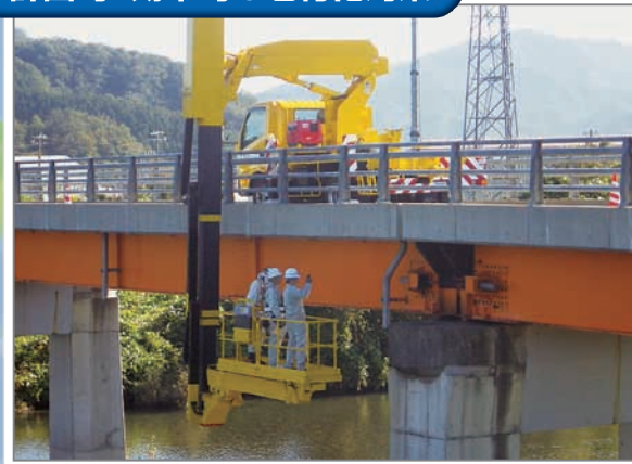
橋梁点検 福富橋〔国道178号〕（新温泉町）
