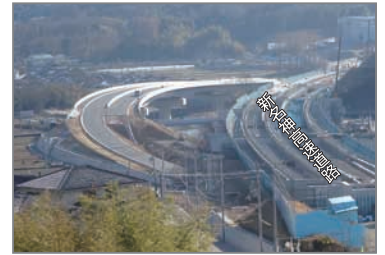
県道 川西インター線 [施工中] (川西市)
