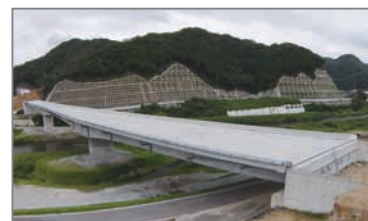
山陰近畿自動車道 浜坂道路[施工中](新温泉町)
