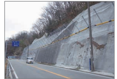
落石防止網 国道173号 (猪名川町)
