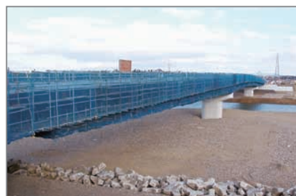
平成25年台風第18号災害 栗田橋 [施工中] (小野市)
