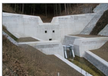
奥ノ谷川砂防えん堤(佐用町)
