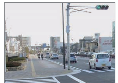
無電柱化による景観形成 都市計画道路 船場川線(姫路市)
