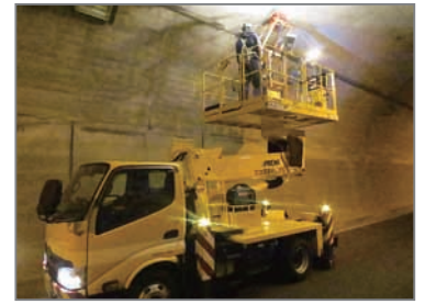
トンネル点検 藤戸トンネル 県道 相生壺根公園線(相生市)
