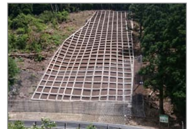
県道 養父宍粟線 道路防災(養父市)
