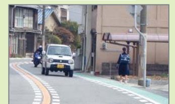
路肩のカラー舗装(グリーン) 国道250号(相生市)
