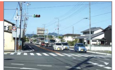
右折レーンの設置 繁昌交差点(加西市)
