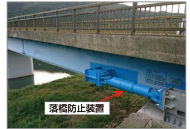
県道 宮津養父線 伊佐橋 橋梁耐震(養父市)
