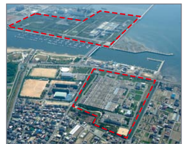
揖保川浄化センター(姫路市)
