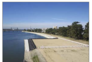
武庫川下流築堤区間の河道拡幅 (西宮市)
