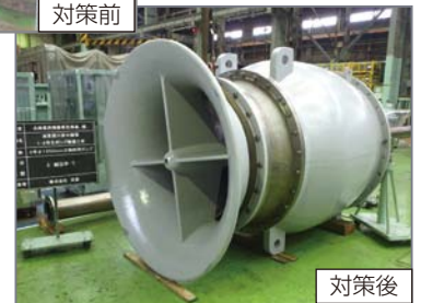
排水ポンプのオーバーホール 加里屋川排水機場 (赤穂市)
