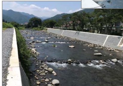
河川中上流部治水対策 八木川(養父市)
