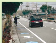
矢羽根型路面表示 県道 多可柏原線(多可町)
