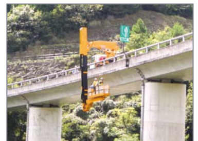
県道 播磨新宮インター線 インター2号橋(たつの市)
