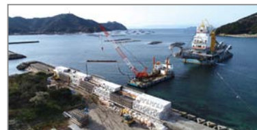
福良港湾口防波堤(南あわじ市)
