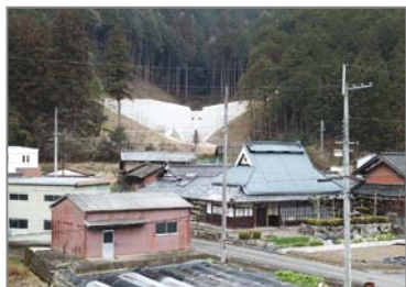
南油良西谷川砂防堰堤(丹波市)
