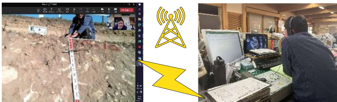
移動時間が短縮可能な遠隔臨場による現場管理
