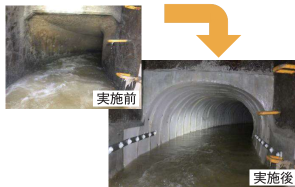
武庫川下流域下水道 右岸第2幹線(西宮市)
