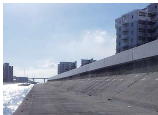
尼崎西宮芦屋港海岸 枝川町地区 防潮堤嵩上げ(西宮市)
