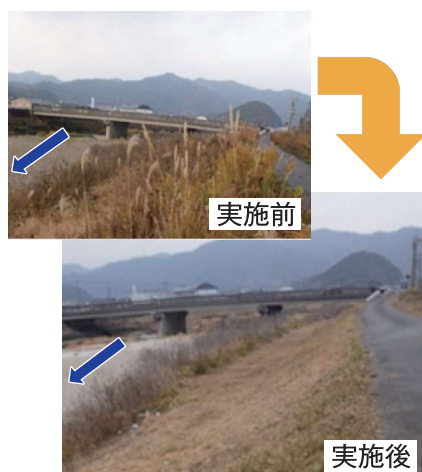
河川堤防の点検前除草(多可町)
