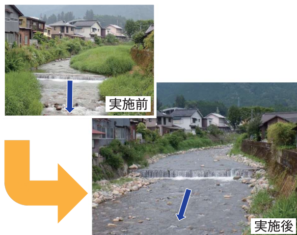
岩野辺川 堆積土砂撤去(宍粟市)
