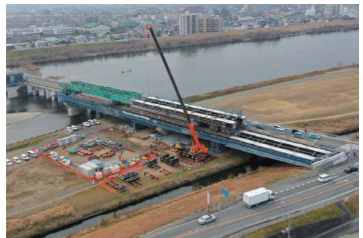
都市計画道路 国道2号線 加古川橋(加古川市)
