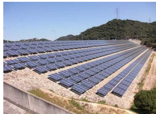
【権現ダム堤体法面】
