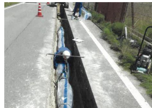
【管路耐震化工事の様子】
