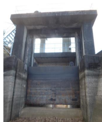
【加古川 平荘ダムゲート】
