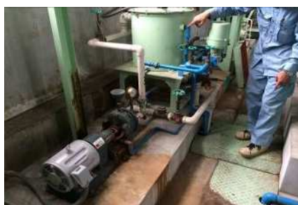
施設の機能診断実施
