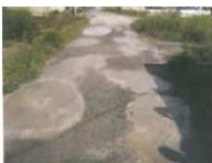
農道の窪みの補修
