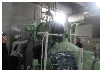
対策工事の実施
