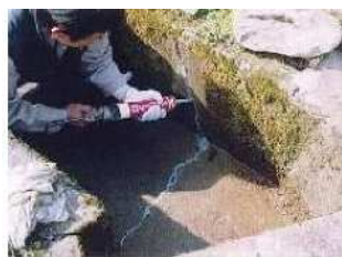
水路のひび割れ補修
