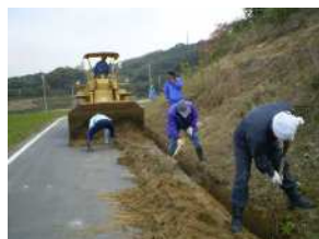
水路の泥上げ
