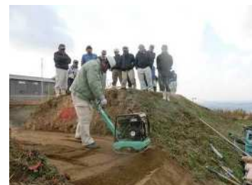
ため池堤体の補修指導
