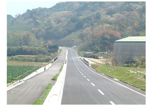
緑工区供用区間
