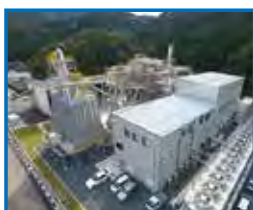
木質バイオマス発電所 (朝来市)
