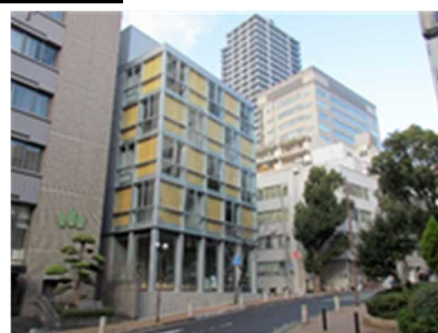
兵庫県林業会館 (神戸市)
